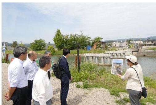
地盤沈下で道路が崩れ、土台だけ残る橋
